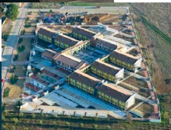
TRABENSOL, Torremocha del Jarama (Madrid)
